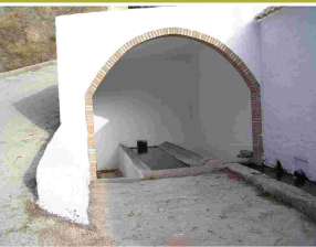
Fuente-Lavadero de Los Caños
